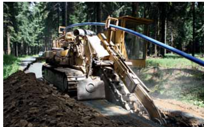
Eine moderne Grabenfräse verlegt das Trinkwasserrohr gleich mit
