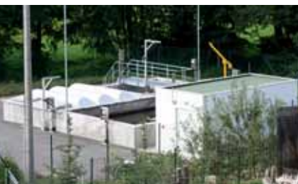
Neubau zentrale Kläranlage Wildenau, fertiggestellt 2008
