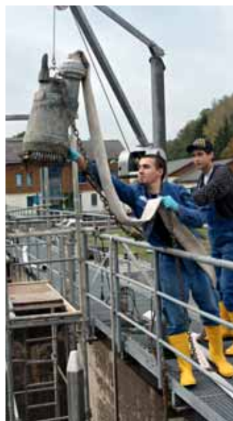
Die Auszubildenden Alexander Heinrich (links) und Dirk Lipinski mit der Abwasserpumpe
