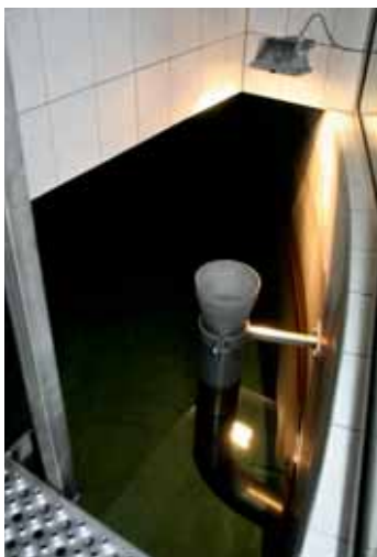
Neu gebauter Wasserbehälter im Reichenbacher Ortsteil Brunn
