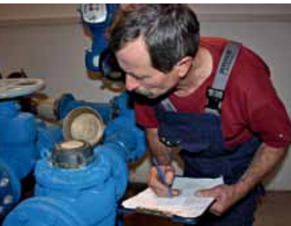
Dieter Sonnemann beim Ablesen eines Großwasserzählers
